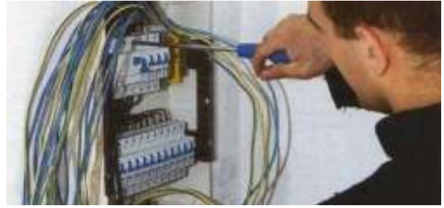
Разводка электротехнических точек 600 руб./точка
